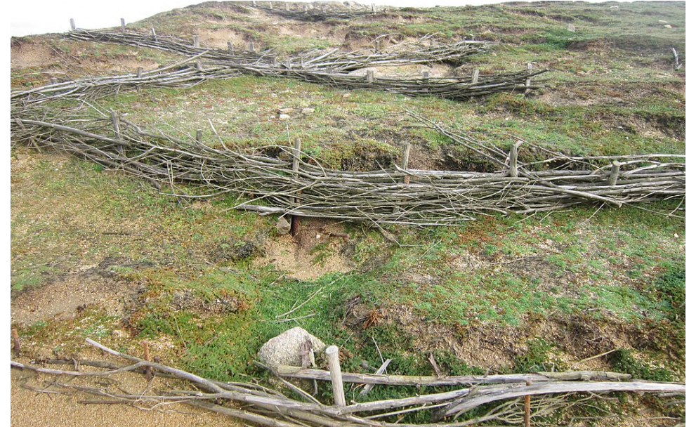
Figure 1: Fascines près de la pointe du Percho (Côte sauvage de Saint-Pierre-Quiberon) protégeant les dunes de l'érosion. Photo de Moreau.henri sous licence Creative Commons BY-SA.
