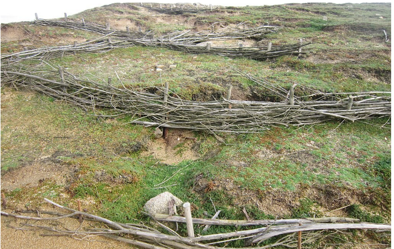
Fascines près de la pointe du Percho (Côte sauvage de Saint-Pierre-Quiberon) protégeant les dunes de l'érosion. Photo de Moreau.henri sous licence Creative Commons BY-SA.
