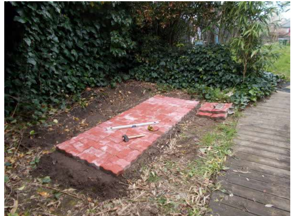
On peut mettre des pavés autobloquants pour limiter la venue de rongeurs. Il existe également des grillages anti-rongeurs.
