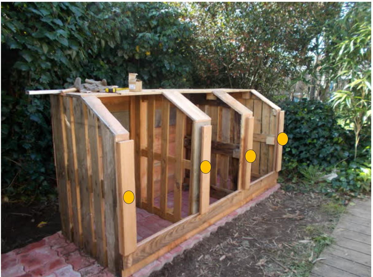
*Glissières entre chaque bac pour pouvoir mettre et retirer des planches facilement pour simplifier l'usage. En bas des glissières se trouve une butée pour retenir les planches.*
